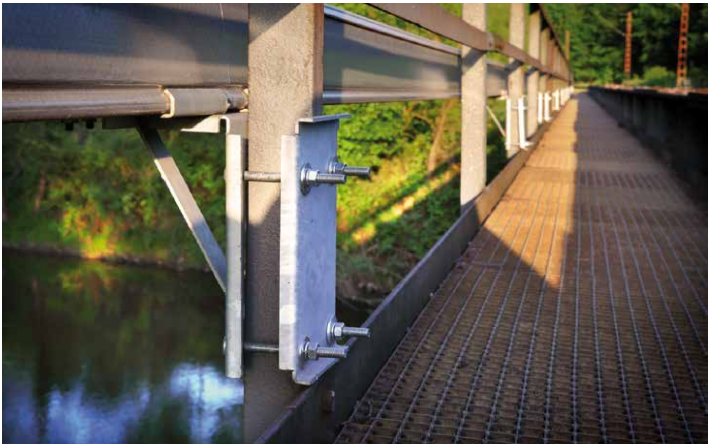
Positionierung der Flachrundschrabe von beiden Seiten möglich
