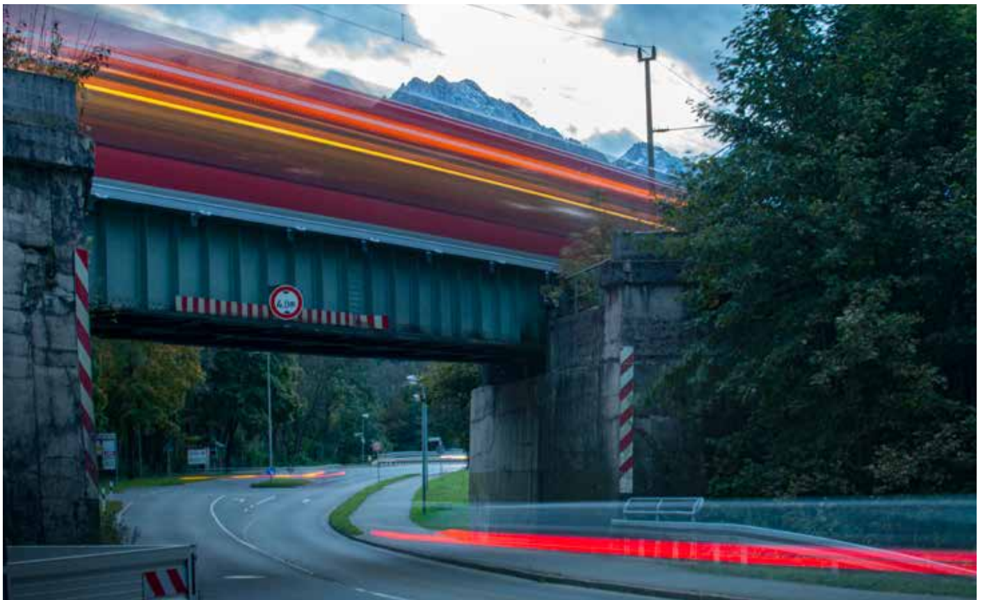
nach der Installation
